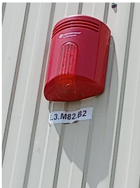
Figura 48. Sirena de alarma acústico luminosa en almacén C6.
