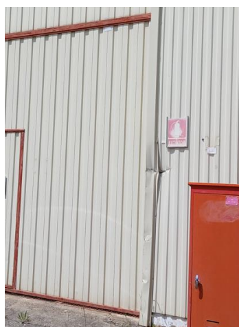
Figura 28: Ejemplo de punto singular en jamba de puerta en almacén C4.
