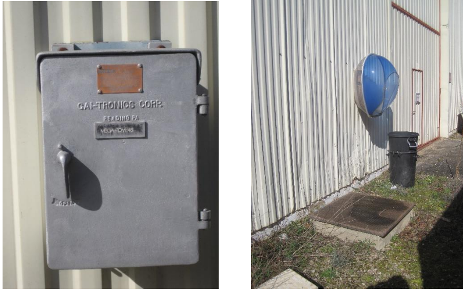
Figura 8: Equipo de megafonia de planta y telefonia en almacén C3.
