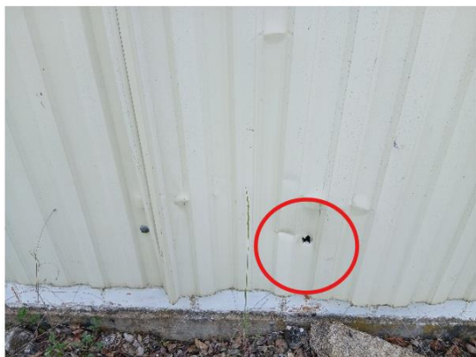
Figura 29: Ejemplos de defectos en cerramiento de fachada a reparar. Taladro en almacén C3 (izquierda) y deformación en solape entre chapas de puerta en almacén C4 (derecha)
