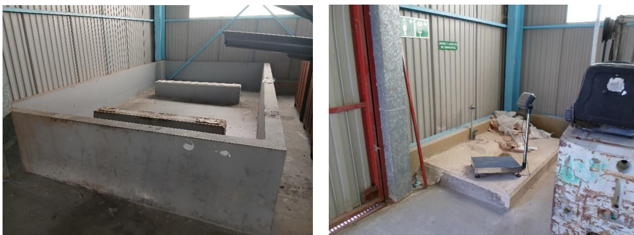
Figura 31: Cubeto de retención en C4 (foto izquierda) y pedestal de ducha en C5 (foto derecha).
