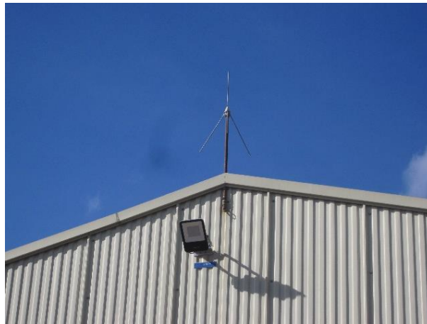
Figura 9: Antena auxiliar comunicaciones en almacén C3.
