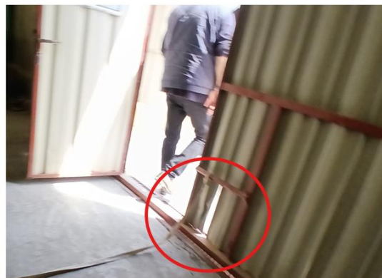
Figura 29: Ejemplos de defectos en cerramiento de fachada a reparar. Taladro en almacén C3 (izquierda) y deformación en solape entre chapas de puerta en almacén C4 (derecha)
