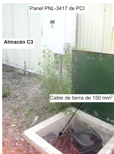
Figura 42: Línea de tierra existente en arqueta junto al almacén C3.
